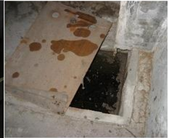
地下室污水池
