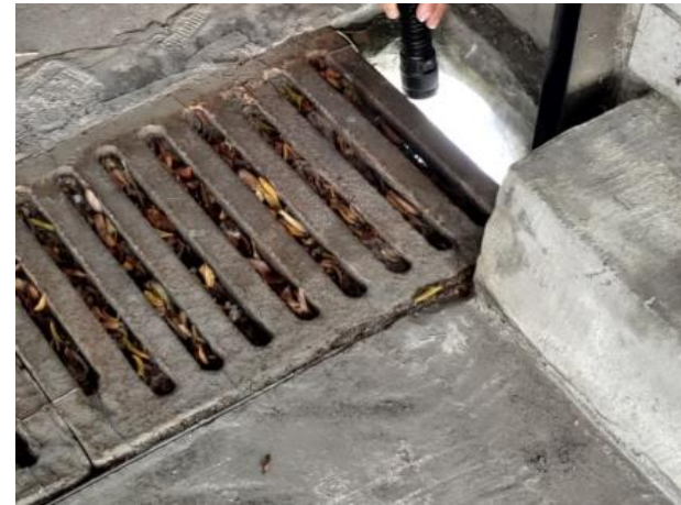
地下室車道水溝
